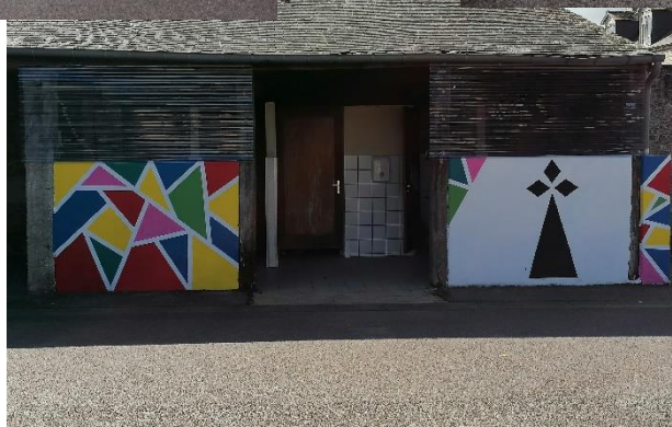
Les toilettes extérieures et la nouvelle fresque
